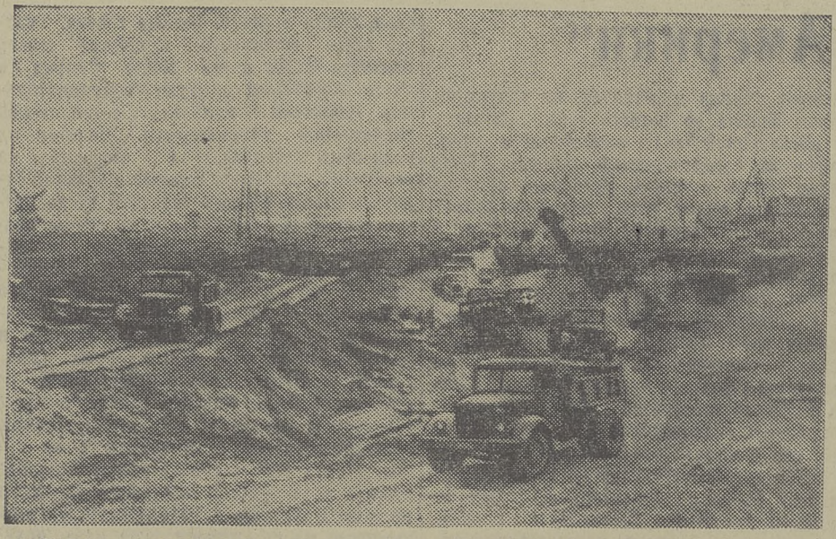
Куйбышевгидрострой. С каждым днем пирируется фронт работ на строительстве Куйбышевской гидроэлектростанции. На рытье котлована для здания электростанции высочайших показателей достигли бригады экскаваторщиков тт. Колосова и Вороновича. Они вынимают экскаваторами с ковшами емкостью в 2,5 кубических метра по 2.000 кубических метров грунта в сутки.
