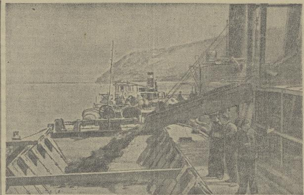
Куйбышевгидрострой. Почти две трети здания гидроэлектростанции войдет в русло Волги. Подводные работы многоочередными землечерпальными снарядами. Земснаряды вынимают за сутки до 6-7 тысяч кубометров грунта со дна Волги, значительно превышая нормы.
