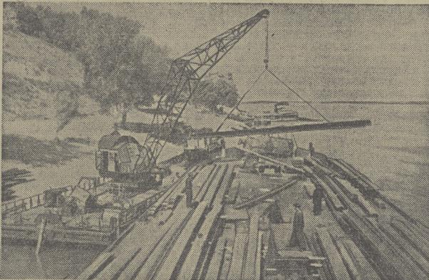
Куйбышевгидрострой. Сотни тонн металла будут уложены в тело плотин Куйбышевской гидроэлектростанции. На снимке: выгрузка шпунтов для плотин Куйбышевской ГЭС в районе строительства. (Фотохроника ТАСС.)
