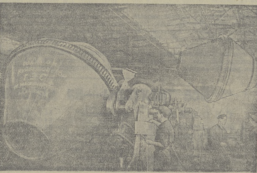
Сталинская область. Славянский завод строительных машин выполняет заказы для великих строек коммунизма. Машиностроители выпускают мощные бетономешалки емкостью в 2,400 и 4,500 литров. Трудящиеся завода получили благодарность от строителей «Куйбышевгидростроя» и «Волгодонстроя» за хорошее качество механизмов.
