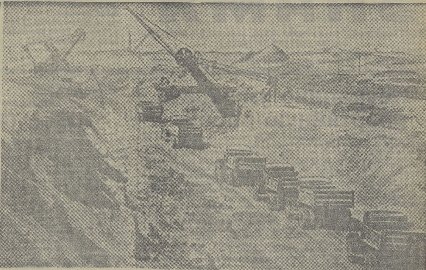
НА СТРОИТЕЛЬСТВЕ ЦИМЛЯНСКОГО ГИДРОУЗЛА.
