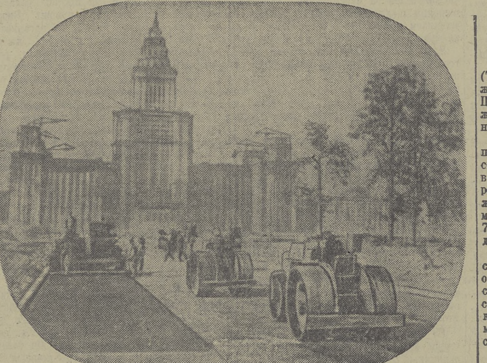
Москва. На строительстве Московского государственного университета на Ленинских горах одновременно с отделкой здания ведутся большие работы по благоустройству огромной территории. Прокладываются прямые и шпирные проспекты-подъезды, строятся бассейны, фонтаны, пруды. На снимке: дорожные работы у главного корпуса Дворца науки. (Фотохроника ТАСС).
