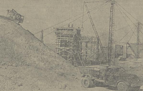
Волгодонстрой. Для железнодорожных путей и нового асфальтированного шоссе Сталинград — Калач через Волго-Донской соединительный канал строятся железобетонные мосты с большими пролетами.
