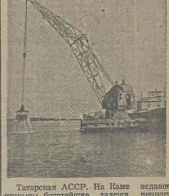
Татарская АССР. На Каме недавно открыты богатейшие залежи ценного строительного материала — гравия. Он залегает в реке мощным слоем, толщина которого доходит до 15 метров. Добыча и отгрузка гравия ведется механизированным способом. Семь пловучих кранов-грейферов добывают для строительства Куйбышевской Механизаторы—водники Камского Устья добывают и грузят каждым краном по 250 тонн гравия в смену— на 50 тонн больше нормы.
