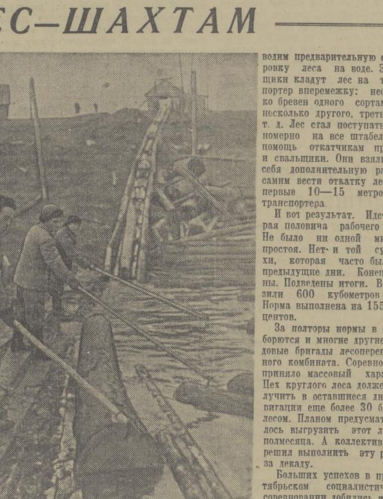
водим предварительную сортировку леса на воде. Зацепщики кладут лес на транспортер попеременно; несколько бревен одного сорта, несколько другого, третьего и т. д. Лес стал поступать равномерно на все штабеля. На помощь откатчикам пришли и сваляшки. Они взяли на себя дополнительную работу: самим вести откатку леса на первые 10—15 метров от транспортера.
