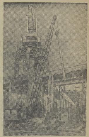
На строительстве Цимлянского гидроузла. На снимке: наращивание металлического шпунта подпорной стенки Цимлянской гидроэлектростанции. (Фотохроника ТАСС).
