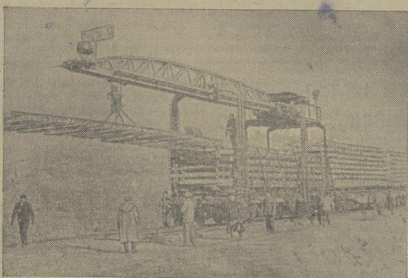
Куйбышевгидроэлектрострой. Бригада дорожного мастера Ф. Е. Садкова на строительстве железнодорожного подъездного пути укладывает при помощи путеукладчика системы Платова по одному километру пути в смену.
