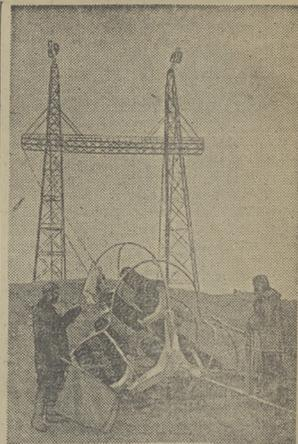
Куйбышевгидрострой. Строители сооружают самый большой в мире воздушный переход высоковольтной линии электропередачи через Волгу. От нагретых гирлянд изоляторов, подвешенных на 48-метровых металлических опорах, через Волгу переникует тонюсущие тросы.
