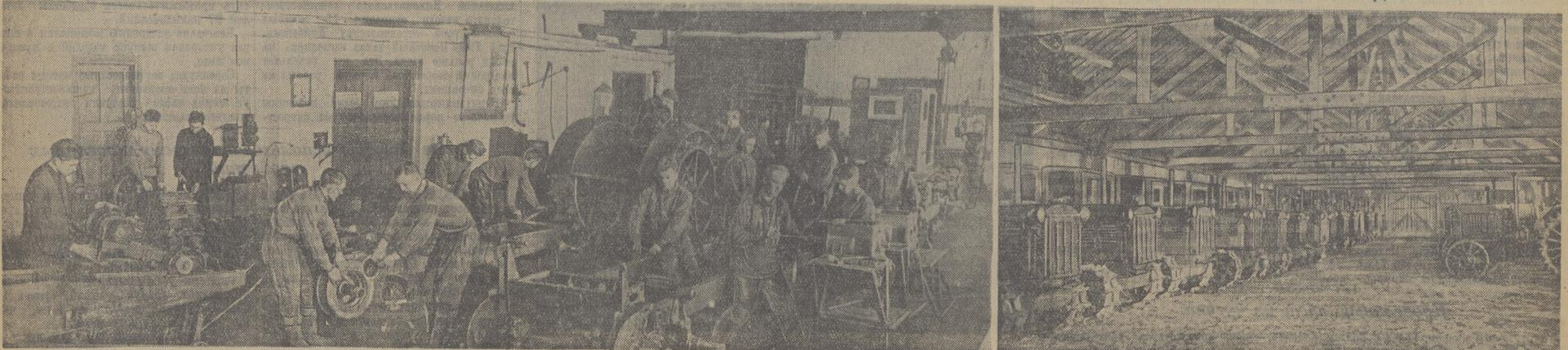
На снимке (слева): вид на поточные линии ремонта тракторов в монтажном цехе Асиновской МТС. Отремонтированные тракторы хранятся в специальном сарае (снимок справа).
