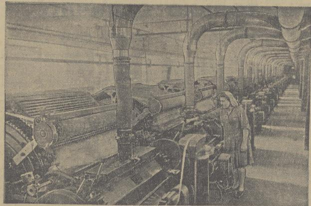
Ленинградские текстильные предприятия непрерывно оснащаются совершенным отечественным оборудованием. На предельно-мощном комбинате имени С. М. Кирова установлены новые кардочесальные машины с пневматической очисткой механизмов от хлопковой пыли. Эти машины не нуждаются в остановке на очистку, выпускают продукцию более высокого качества и оздоравливают условия труда.
