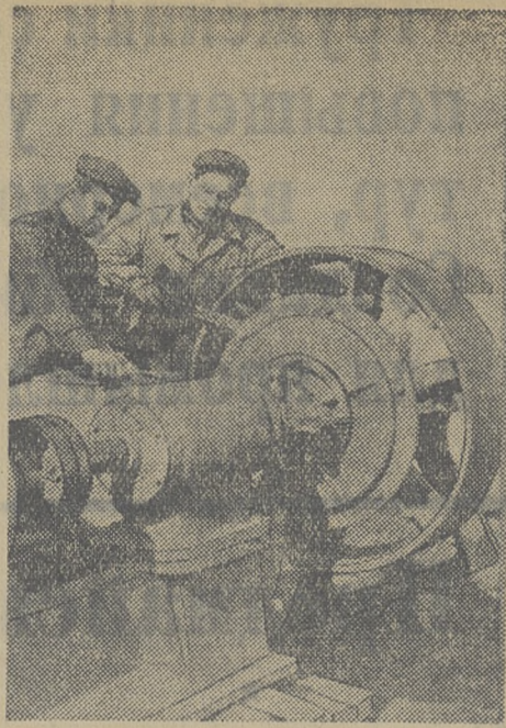
На Томском кирпичном заводе № 10 идут подготовительные работы и легкому сезону. Цехи оснащаются передовой современной техникой...
