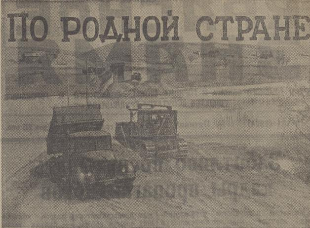
На Сталинградгидростроителе возводится верховая перемычка основного котлована гидростроения. На снимке: разгрузка автомашин на верховой перемычке. (Фотохроника ТАСС).
