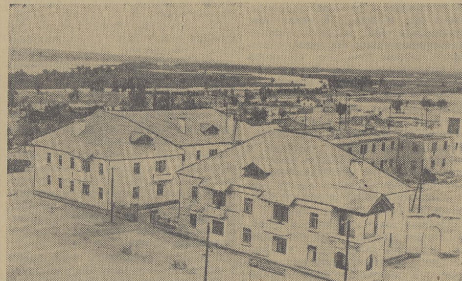
Новая Каховка. Выполняя обязательства, взятые в письме товарищу И. В. Сталину, строители Каховского гидроузла успешно борются за досрочную сдачу в эксплуатацию 40 тысяч квадратных метров жилой площади. Уже построены десятки двухэтажных домов. На снимке: новые жилые дома в 8-м квартале. (Фотохроника ТАСС).
