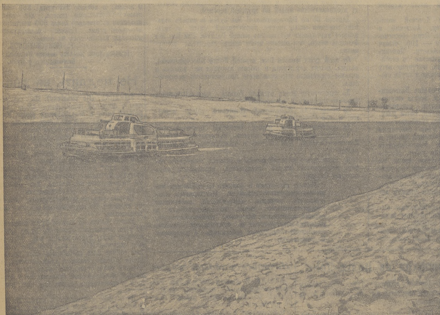
Волгодонстрой. На одном из участков Волго-Донского судоходного канала.
