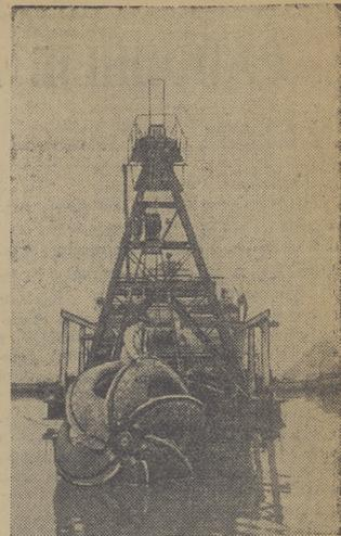
Куйбышевгидрострой. На Волге, в районе сооружения величайшей в мире Куйбышевской гидроэлектростанции, успешно применяются мощные земснаряды типа «Сталинградский 1.000-80». За сутки они вынимают со дна реки и перемещают по трубопроводам тысячи кубометров грунта.
