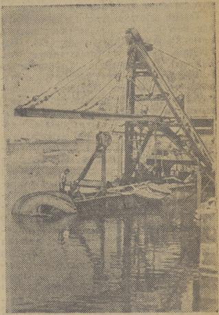
Новая Каховка. Строители Каховского гидроузла получают мощную технику. Сейчас идет монтаж земснаряда «1000-80». На снимке: монтаж рыхлителя и стрелы земснаряда. (Фотохроника ТАСС).
