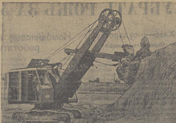
Томский кирпичный завод № 10 недавно получил однокорпусный экскаватор, который сейчас используется для заготовки сырья на зимний период. Эта работа раньше велась вручную, была малопроизводительной. Сейчас производительность труда возросла в шесть раз. Сократилось количество рабочих, снизилась себестоимость сырья. На снимке: экскаватор за работой в карьере, экскаваторщик М. Н. Горьков. Фото Ф. Хитриневича.
