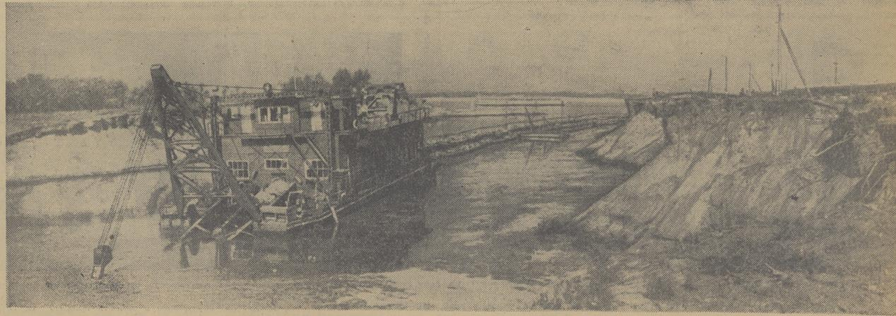
Сталинградгидрострой. На строительстве судоходного канала Волга—Ахты ба. Земснаряд «502» вынимает грунт на трассе канала. (Фотохроника ТАСС).
