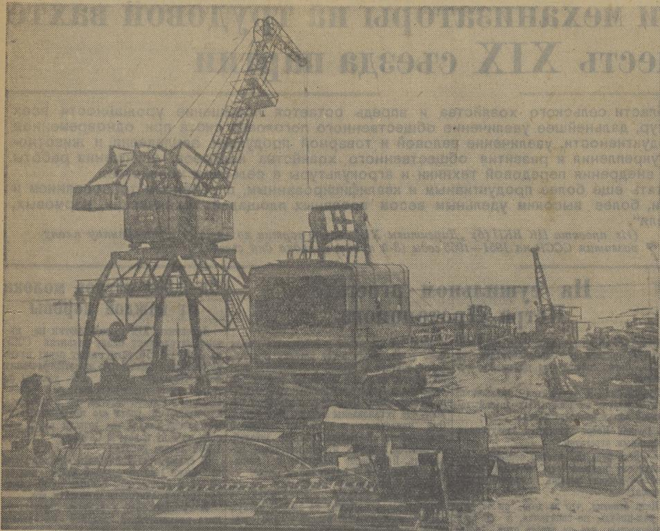
Тахиа-Таш. На монтажной площадке в Тахиа-Таше в момент сборки семикубового электрического экскаватора. (Фотохроника ТАСС).
