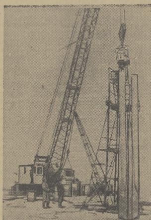
Сталинградгидрострой. На Песчаном острове начато строительство перемычки, которая оградит котлован основных гидросооружений. На снимке: забивка шпунта. (Фотохроника ТАСС).
