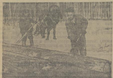
Лошадь, волокуша, вага — вот с помощью чего трелевался (подвозился) лес. Натужившись, медленно переставляя ноги, волочила лошадедна по глубокому снегу тяжелые бревна из лесосеки к штабелям. Немало силы затрачивал подвозчик на то, чтобы лишь при помощи ваги поднять конец бревна на волокушу, затем сгрузить его на верхнем саладе и поднять на штабель.
