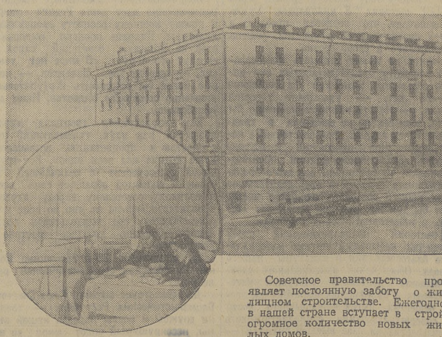
На снимке: здание нового общежития Томского политехнического института, построенное в этом году. В овале: одна из комнат этого общежития.
