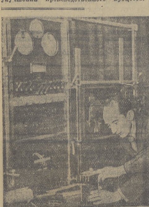
Рационализаторы районного управления «Томэнерго» — начальник службы наладки тепловых процессов и автоматики тов. Маркман и слесари по автоматике тт. Ким и Тимофеев предложили и внедрили ценную установку, автоматизирующую подачу воды в котел. На снимке: (слева направо) З. И. Маркман, Г. А. Ким и Е. А. Тимофеев в теплоизмерительной лаборатории.
