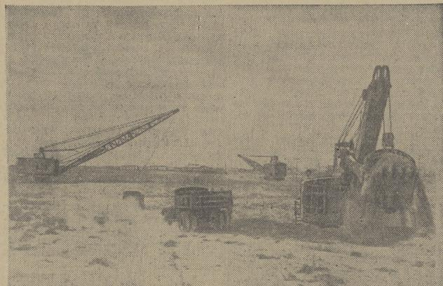
Тяга-Таш. На строительстве обводного канала день и ночь не умолкает шум моторов, все больше и больше землеройных машин вступает в действие. Бульдозеры, скреперы, мощные экскаваторы производят выемку грунта. На снимке: электрические экскаваторы на трассе обводного канала. (Фотохроника ТАСС).
