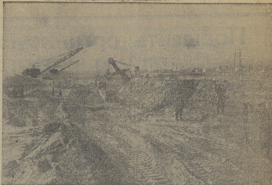
Тахта-Таш. Строительство обводного канала.
