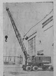
Одесса. Завод имени Пинарского востановил выпуск новых дизель-электрических машин на электромеханическом ходу. Он предназначен для проведения работ по восстановлению и монтажу работ. Стрела крана может подняться с помощью системы до 25 метров. Поднять груз на высоту 25-метрового дома. Кран обладает высокой маневренностью, самостоятельно передвигается по железобетонным козлам по грунту и по мостовым дорогам. На снимке: 25-тонный дизель-электрический кран. (Фотохроника ТАСС).
