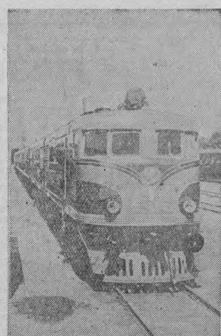
Харьков. Коллектив завода транспортного машиностроения, следуя примеру ново-кратовских машиностроителей, соревнуется за снижение веса и улучшение качества выпускаемых газогенераторных тепловозов. Недавно заводом выпущен новый газогенераторный тепловоз «ТЭ-2», вес которого облегчен более чем на 500 килограммов. На снимке: новый тепловоз «ТЭ-2». (Фотохроника ТАСС.)
