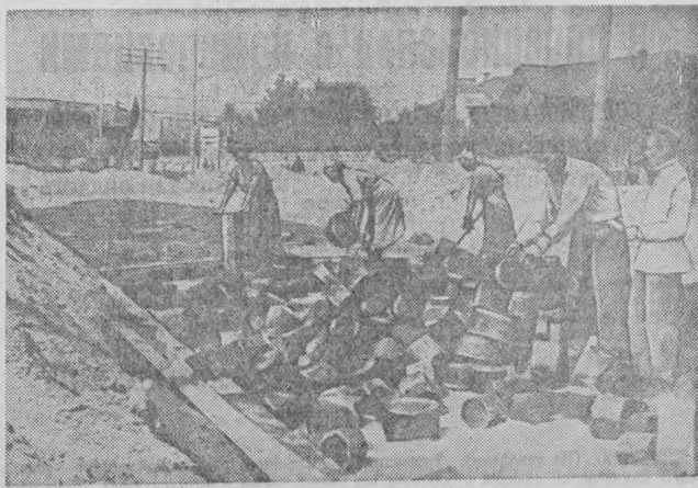
В г. Колпашево широко ведется мостовое строительство. Торцевой мостовой уже покрыты 6 улиц города, что составляет свыше 39 тысяч квадратных метров. В текущем году намечено замостить еще 5 тысяч квадратных метров. На снимке: прокладка торцевой мостовой по Советской улице в Колпашево. Фото Ф. Хитриневича.
