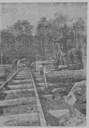
На снимке: прокладка железнодорожного пути для вывозки древесины по сортам. На переднем плане мастер подготовительных работ П. С. Христина. Фото Н. Борисова.
