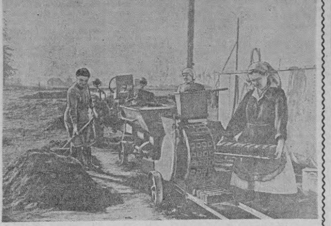
Станок имеет электромотор, а также может приводиться в движение от трактора. За исключением ручной загрузки бункера торфоперенной массой все операции совершаются механическим путем. Во время испытания машина производила за час 9.000 маленьких и 3.500 больших горшочков. В 1954 году наша про-
