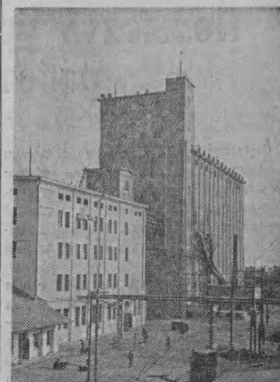
Краснодарский край. В станице Красноармейской скоро вступит в строй действующих предприятий большой крупной завод. В сутки он будет обрабатывать 120 тонн риса. Сейчас ведется монтаж оборудования.
