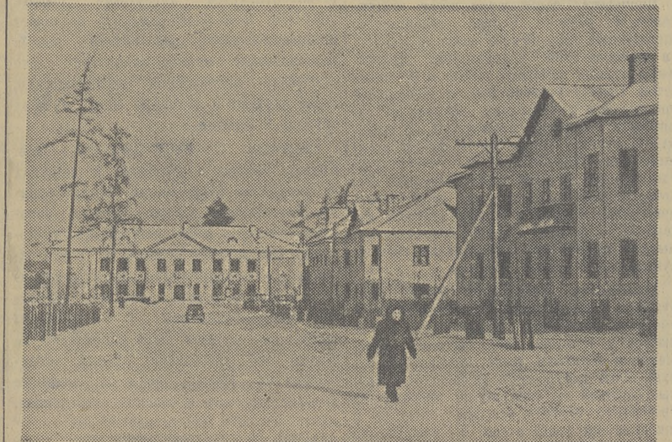
Молотовская область. Для строителей Камской гидроэлектростанции на правом берегу Камы выстроен поселок Гайва с благоустроенными домами, школами и другими культурно-бытовыми учреждениями. На снимке: в поселке Гайва. (Фотохроника ТАСС).
