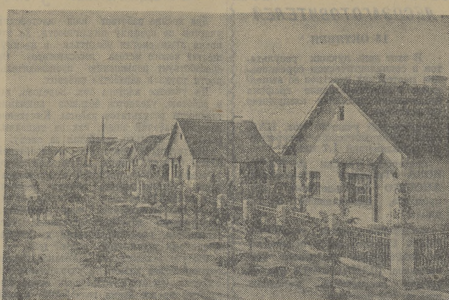
Каменская область. Большие строительные работы ведутся в поселке энергетиков Цимлянск ГЭС. Скоро вступят в строй гостиница, Дворец культуры, еще несколько жилых домов, детские учреждения, магазины. На снимке: улица Жуковского.
