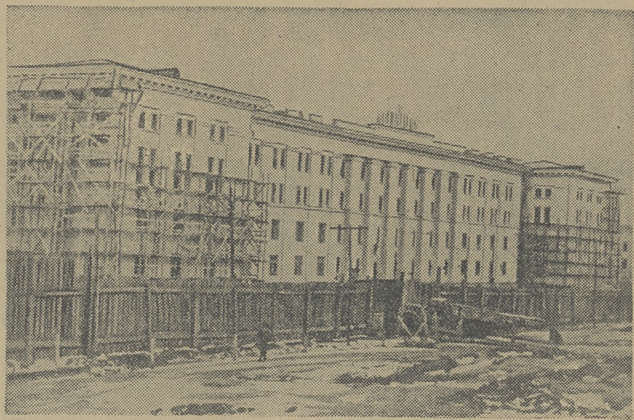
Томск сегодня. На снимке: строящееся здание нового учебного корпуса Томского политехнического института имени С. М. Кирова. Фото Ф. Хитриневича.
