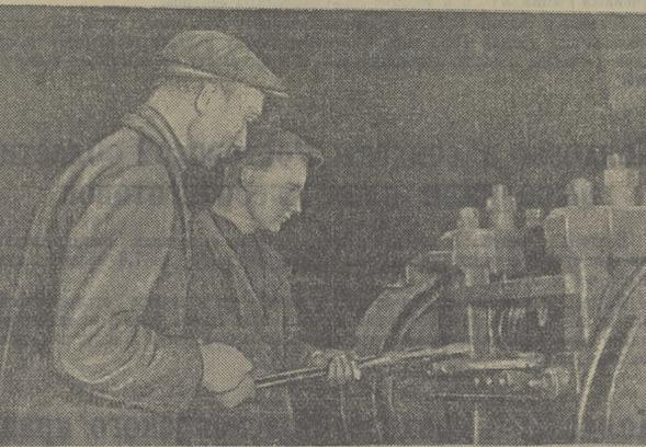
На Томском заводе режущих инструментов осваивается производство витых сверл. На снимке: бригадир-прокатчик А. В. Самцов и мастер участка витых сверл Ф. А. Юрицын за работой на прокатном станке.
