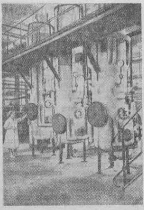
На Московском гидрогенерационном заводе построена первая установка для непрерывной рафинации растительных масел. Преимущество ее перед существующим оборудованием для рафинации, занимающим большие производственные площади, заключается в малогабаритности, простоте устройства, в непрерывности самого процесса рафинации. Установка оборудована автоматическим управлением. Производительность ее — 25 тонн масла в сутки.
