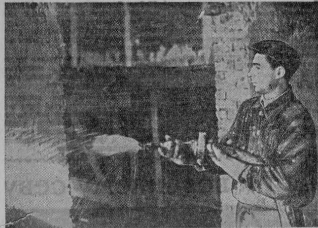
Бригада штукатуров треста «Томскстрой», которой руководит тов. Рейхерт, освоила механизированный способ штукатурных работ. Она выполняет сменную норму выработки на 120—130 процентов. На снимке: В. И. Рейхерт за набрасыванием раствора штукатурным агрегатом.
