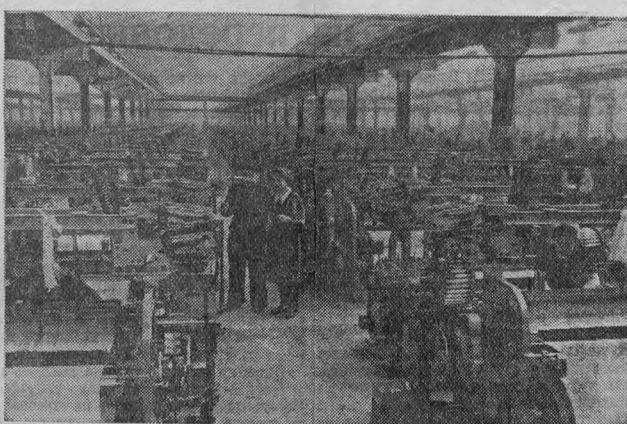
Алтайский край. В Барнауле сооружается крупнейший в Сибири хлопчатобумажный комбинат. Начиная выпускать продукцию предприятия первой очереди. Первые тысячи метров ткани изготовила новая фабрика № 1.
