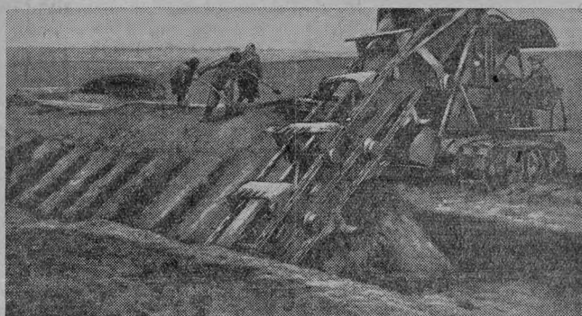
Украинская ССР. В колхозах Львовской области широко развернулось строительство плотинных сооружений. Механизаторы Неслуховской МТС на сооружении плотинных сооружений применяют многоковшовый экскаватор. На снимке: рытье плотинных траншей в колхозе имени Молотова, Ново-Милитинского района. (Фотохроника ТАСС).
