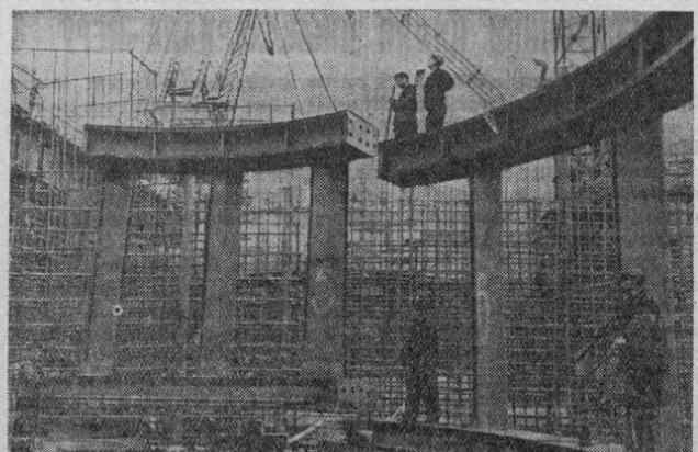
На строительстве Куйбышевского гидроузла начался монтаж и установка первых гидротурбин. Бригады квалифицированных монтажников успешно ведут эту работу. На снимке: монтаж сегментов второго статора. (Фотохроника ТАСС)
