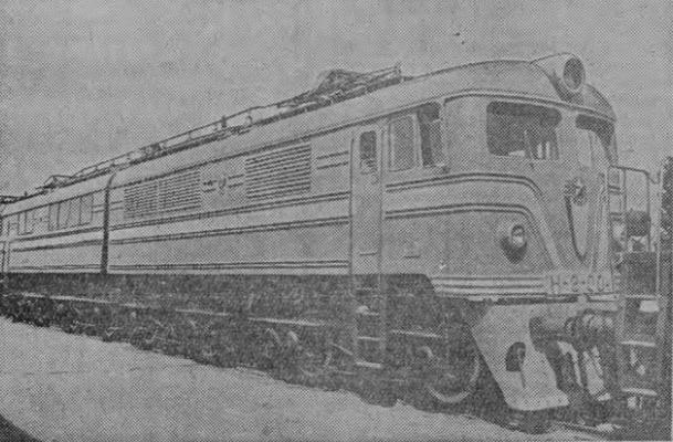
Восьмиосный грузовой электровоз «Н-8», построенный Новочеркасским электровозостроительным заводом имени С. М. Буденного, предназначен для магистральной трудного профиля Сибири и Урала. Мощность его — 5.700 лошадиных сил, конструкционная скорость — 90 километров в час. Скорость движения на девятикилометровом подъеме — 42 километра в час. На снимке: новый грузовой электровоз «Н-8».
