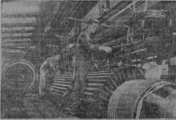
Ленинград. Коллектив турборепаратурного завода «Электросила» имени С. М. Кирова стал на трудовую вахту в честь XX съезда КПСС. Хорошо в эти дни работала бригада обмотчиков А. С. Шилова. Сейчас она заканчивает выпуск очередного ротора турбогенератора мощностью в 50 тысяч киловатт. На снимке: обмотчик В. И. Саморуков и бригадир А. С. Шиллов (на первом плане) за укладкой обмотки второго ротора турбогенератора мощностью в 50 тысяч киловатт. (Фотохроника ТАСС).
