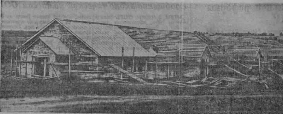
В колхозе имени Сталина, Туганского района, заканчивается строительство типового кирпичного коровника на 120 голов. Кирпич для строительства изготовлен на месте в колхозе. Новое помещение будет покрыто цинфером. Монтируется подвесная дорога, электропроводка и автоподъемники. На снимке: строящийся коровник. Фото Ф. Хитриневича.
