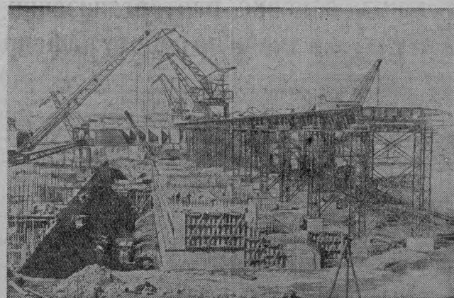
Строителям Новосибирской ГЭС в этом году предстоит уложить 220 тысяч кубометров бетона, смонтировать 4,5 тысячи тонн металлических конструкций, выполнить значительный объем земляных работ. На всех участках стройки развернулось социалистическое соревнование за достойную встречу XX съезда КПСС.
