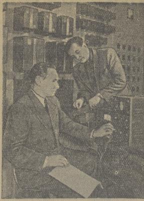
Рига. Коллектив «Латвэнерго» проводит телемеханизацию электростанций и электроподстанций. Кегумская ГЭС переведена на телеуправление из центрального диспетчерского пункта. С помощью телемеханики производится пуск и остановка гидроагрегатов, контролируется распределение нагрузки по отдельным электростанциям и линиям, напряжение генераторов и т. д.
