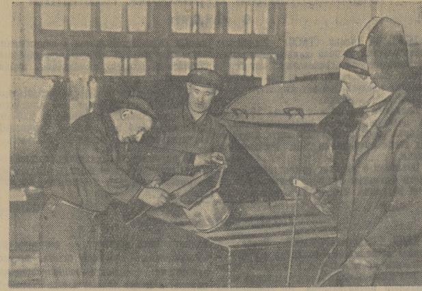
Коллектив кузнечно-механического цеха вагонного участка станции Томск-II в порядке шефской помощи изготовляет для Асиновской МТС четыре кузнечных горна с полным оборудованием. На снимке: кузнец М. П. Теплых, молотобоец Г. П. Михайлин и электросварщик С. П. Гуделин за сборкой последнего горна. Фото Ф. Хитриневича.
