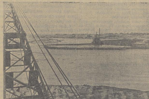
Полтавская область. По шестому пятилетнему плану на Днепре намечено построить и ввести в действие Кременчугскую ГЭС мощностью 450 тысяч киловатт. Сейчас здесь идет строительство жилых домов для рабочих, завода железобетонных конструкций и других подсобных предприятий. Гидромеханизаторы с помощью земснарядов намывают ограждающую перемычку.
