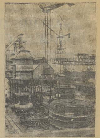
Днепропетровская область. На металлургическом заводе имени Дзержинского строится мощная доменная печь № 12. Она будет работать на повышенном давлении газов. Коллектив треста «Дзержинстрой» обязался построить печь со всеми вспомогательными сооружениями за шесть месяцев. На снимке: общий вид строительства доменной печи № 12. (Фотохроника ТАСС).
