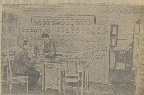
Сталинская область. В третьем механическом цехе ново-краматорского машиностроительного завода имени Сталина закончено оборудование первой в стране системы автоматического учета работы металлорежущих станков и внутрицеховой сигнализации. Аппаратура изготовлена по заказу машиностроителей Ленинградским институтом точной механики и оптики.
